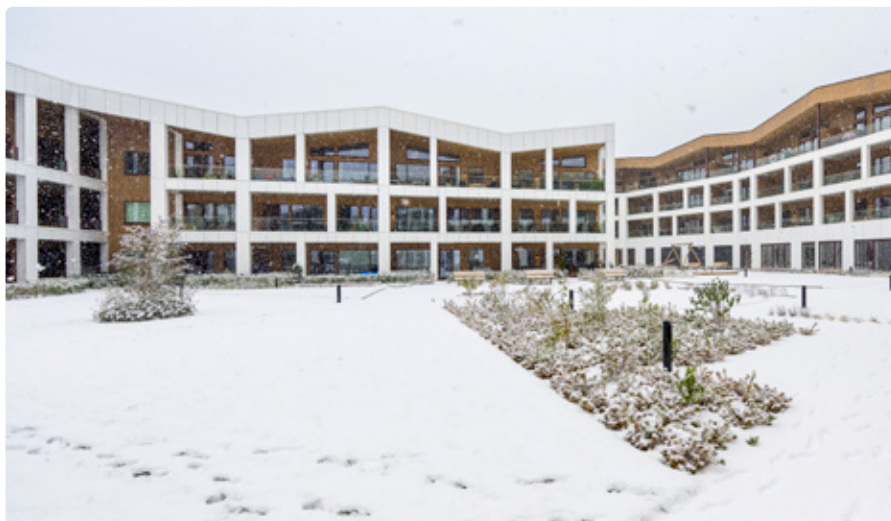
Vennesla Atrium er et praktbygg – også når Kong Vinter har fargelagt det.
