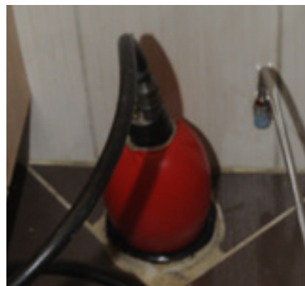
⌘ Her føres rørstrømpen inn i det gamle røret.
