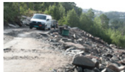
⌘ Arbeidet med veien og tomtene er i full gang.
