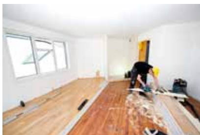
Tømrer Frode Bjørnstad fra KEAS er godt i gang med rehabiliteringen av de 25 kvadratmeter store hybelleilighetene som snart skal selges.
