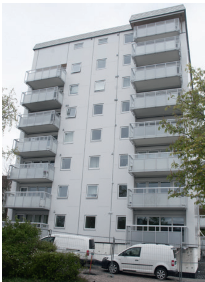
Balkongspesialisten Balco er ferdig med montering av nye balkonger på en av de tre blokkene.
