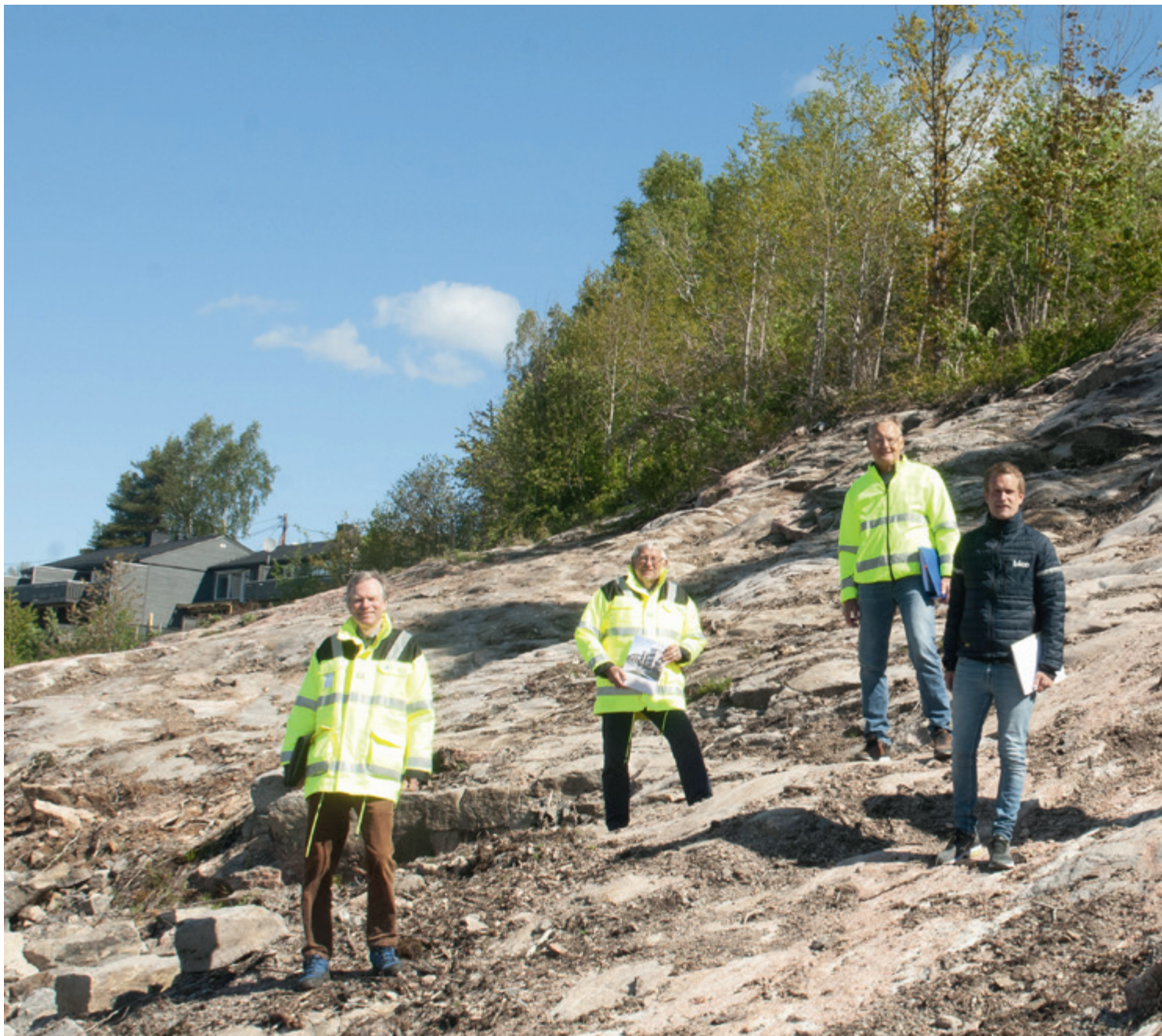
De står der en av bygningene i første byggetrinn skal reises: Fra venstre: Odd Helge Moen, Ole Fritjof Godtfredsen, henholdsvis teknisk sjef og adm. dir. i Sørlandet Boligbyggelag, David Knudsen, prosjektleder hos Kaspar Strømme, Jens Korsvik, prosjektleder hos Bico AS og Hans Loland, anleggsleder hos Kaspar Strømme.
