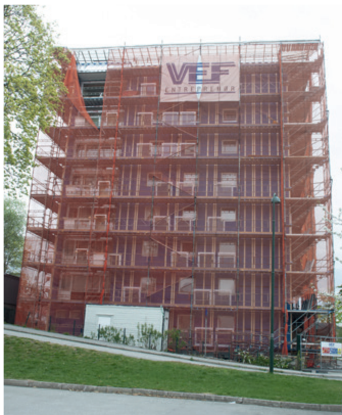
Arbeidet går som planlagt; VEF Entreprenør jobber med kutting av balkongene på den siste av de tre blokkene.
