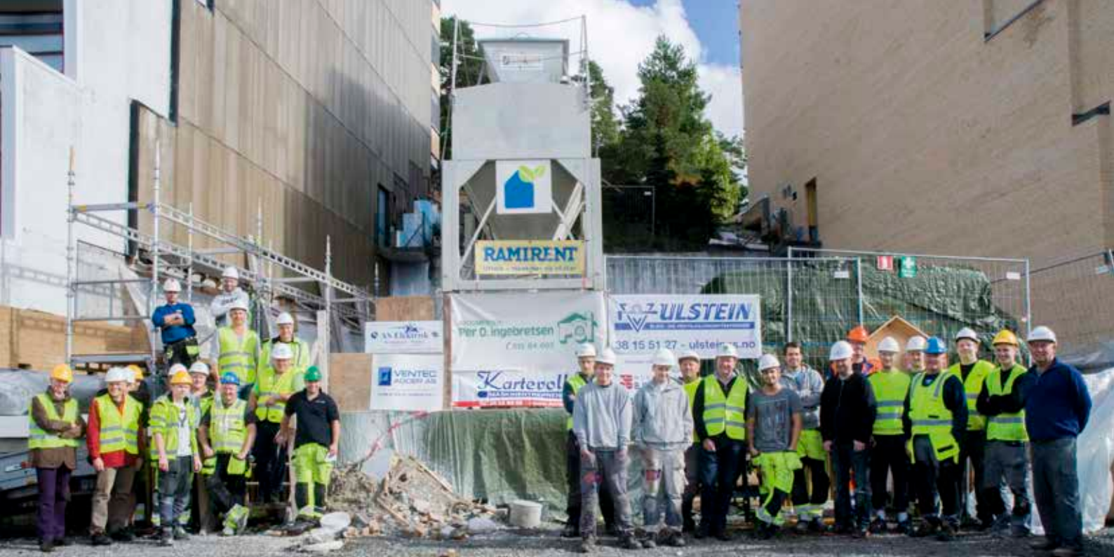
Rehabiliteringen av Vigvoll Terrasse Borettslag er godt i gang. Veggene til høyre i bildet har fått ny teglstein på fasaden.
