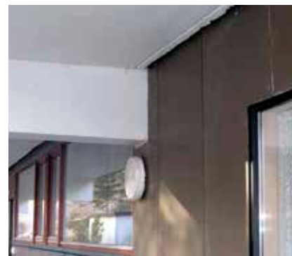
Termografering med varmekamera fanger opp forskjeller i konstruksjonens overflatetemperatur. Dette ble gjort med Vigvoll Terrasse Borettslag, og termobildene viser en sterk varmestrom ved drageren som fører varmen ut av bygget.
