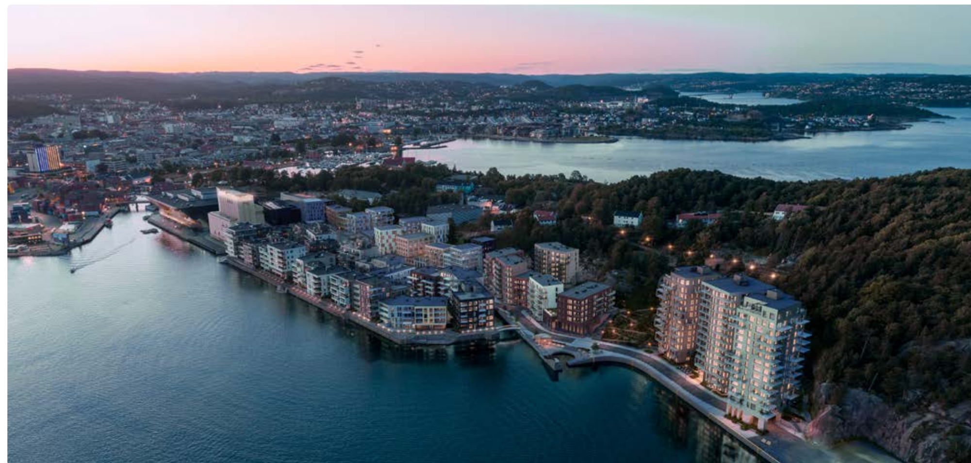
Det nye byggetrinnet ligger nærmest De tre søstre .
