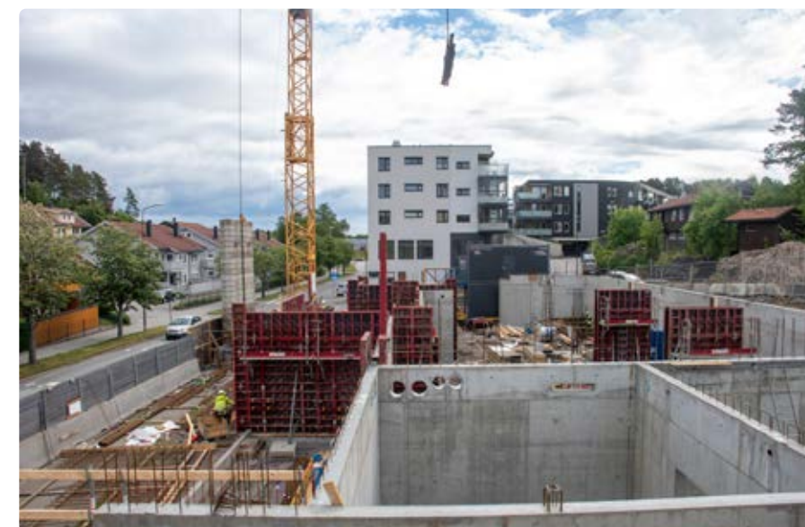
Byggingen er i gang – bildet er tatt i slutten av mai. Det er Mur i Sør AS som er totalentreprenør. Noen av de andre firmaene som er med i prosjektet er Sørlandstak AS, EK Elektro AS, Moi Rør AS og Fjellestad & Heggland AS.
