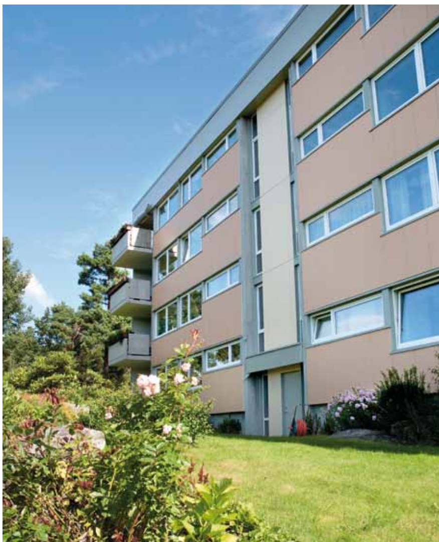
Tinnbo Borettslag har blant annet fått nye fasadeplater.
