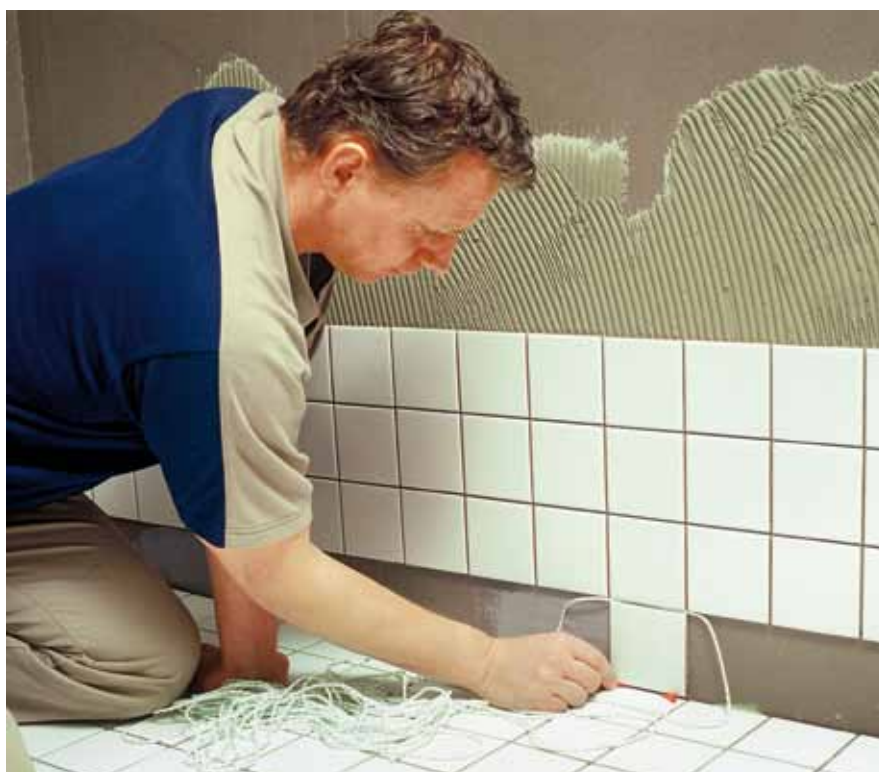
Å fliselegge er ikke så vanskelig, det er underlaget som er viktig. Bruk fagfolk til dette arbeidet. (Foto: Informasjonskontoret for Farge og Interiør).
