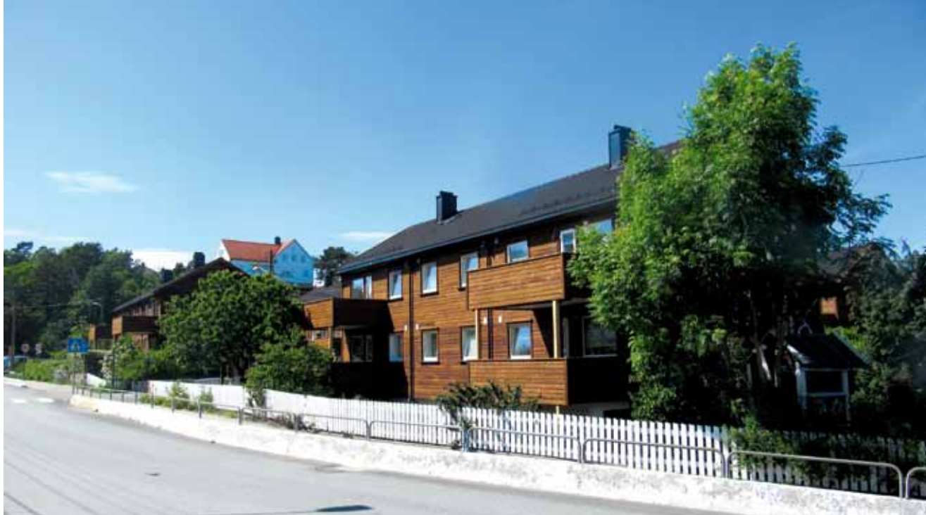
Vågsbygd Borettslag har rehabilitert boenhetene til lavenergi boliger. Det betyr redusert energiforbruk.
