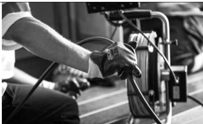
➤ Norva24 anbefaler jevnlig kontroll og vedlikehold av rørene.
