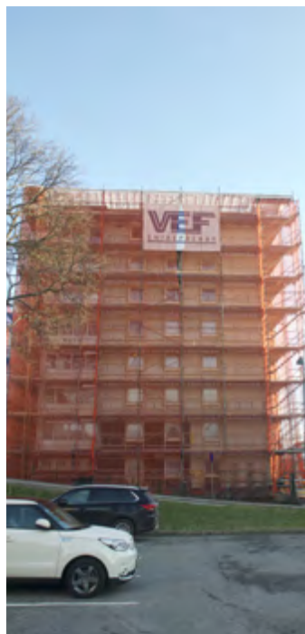
⤴ VEF Entreprenører jobber med rehabilitering av den andre av de tre blokkene i Øvre Tordenskjoldsgate Borettslag.
