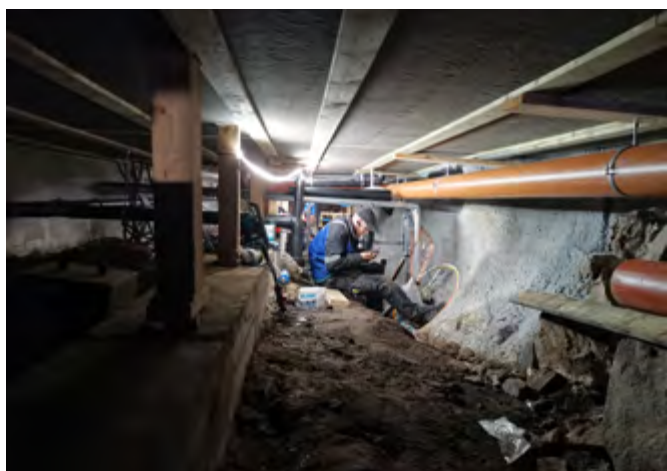
⤴ Asbjørn Hobbesland skjøter hovedkabel til kornmagasinet på Boen Gård.
