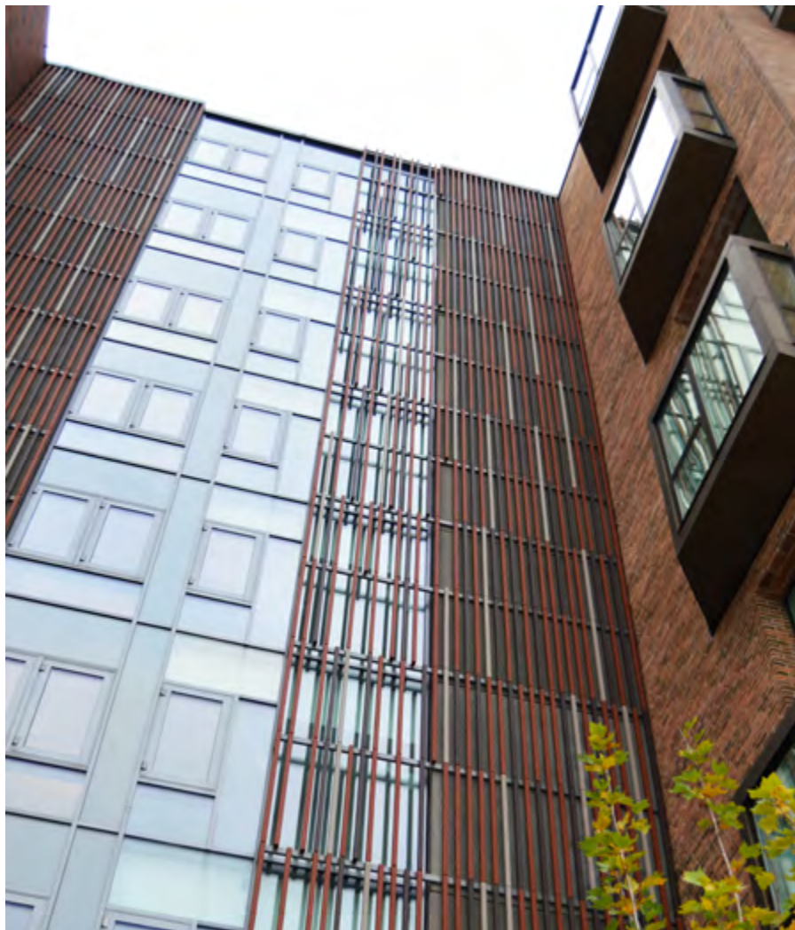
⌘ Med keramiske fliser får du ikke bare en flott fasade, den får også lang levetid, er så godt som vedlikeholdsfri og energieffektiv. (Alle foto: Modena)
