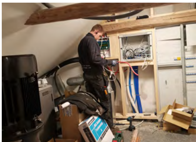
⤴ Her er Lennart Dybesland i gang med å koblinger på brannvarslingsanlegget.
