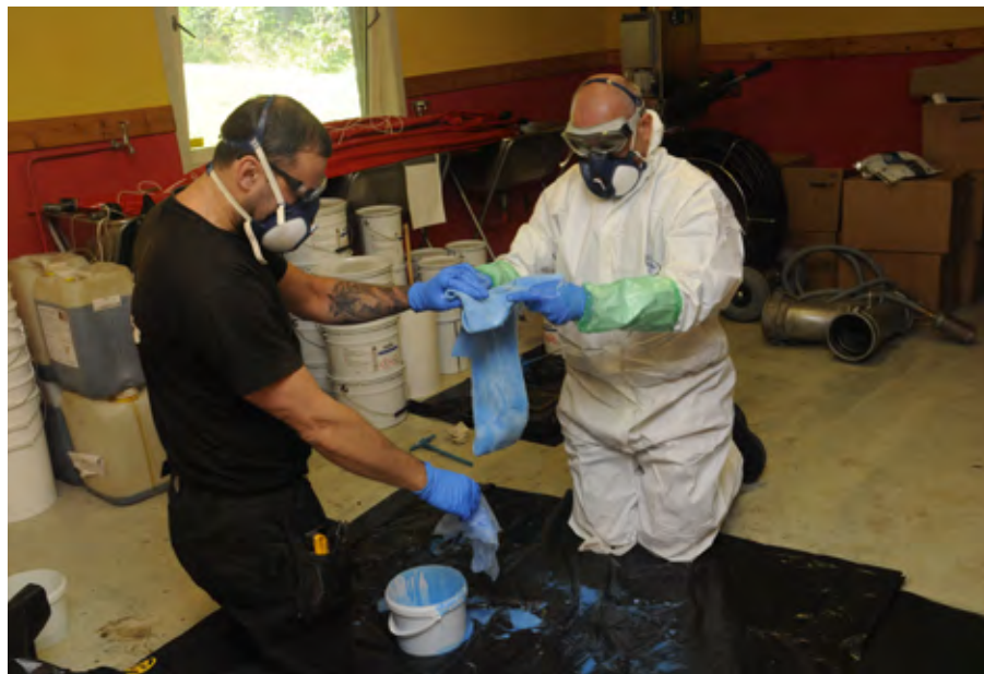
⚡ Fra oppdraget i Ringveien Borettslag - her arbeides det med å mette strømpen med epoxy.
