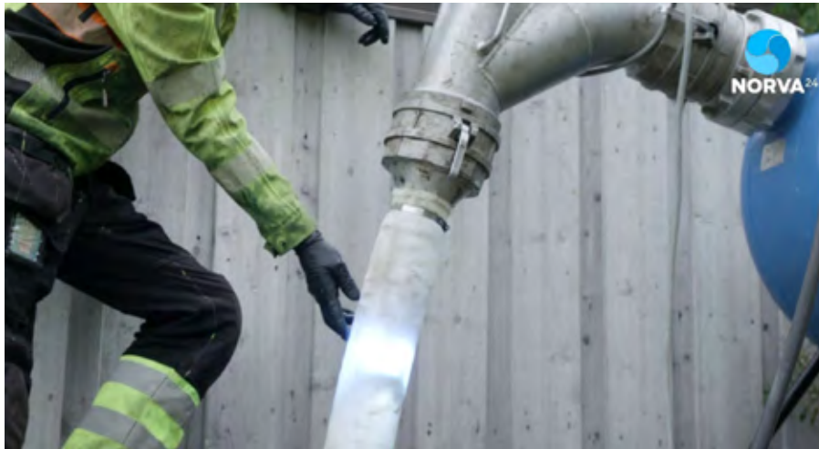
En skreddersydd strømpe føres inn i det gamle røret – og avløpsrøret blir som nytt.
