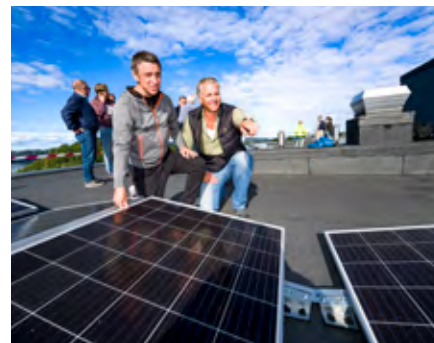
⤴ Jarle Upsahl fra Tratec AS (t.v.) og Christian Zachariassen fra Sørlandet Boligbyggelag på taket til Vigvoll Terrasse Borettslag.
