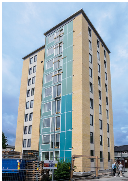
Nå mangler kun balkonger og oppgradering ved inngangspartiet før blokk 11 i Høybygg Borettslag er ferdig rehabilitert.
