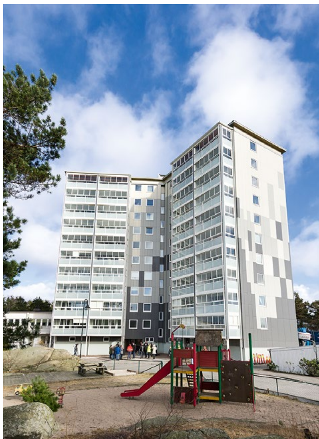
Stjernehus Borettslag er blitt så flott at det vant årets Byggepris, som Kristiansand Byggeforum deler ut hvert år.
