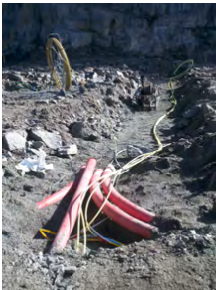
⚡ I midten av september sørget Otera for å legge alle el-kabler i bakken.
