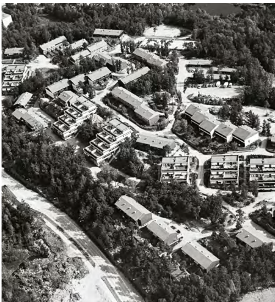
⌘ Ringveien Borettslag, de fire lavblokkene øverst på bildet, og Briggveien Borettslag stod ferdig i første halvdel av 1970-årene.
