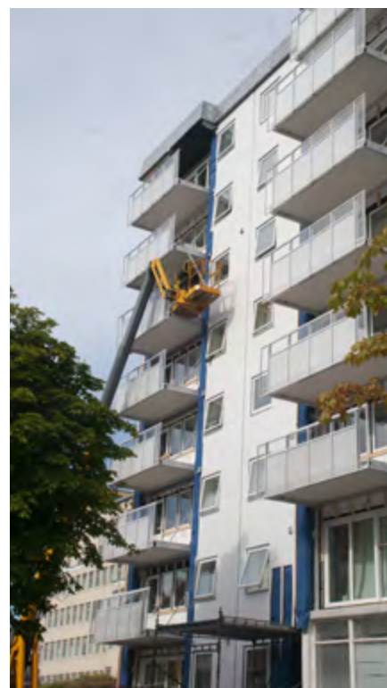
Balkongspesialisten Balco monterer nye balkonger.
