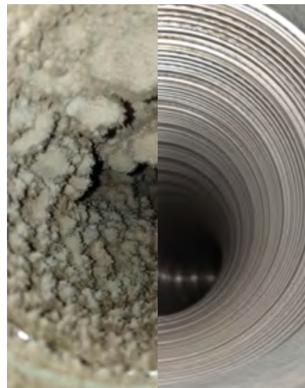
Avtrekkskanaler før og etter rens.
