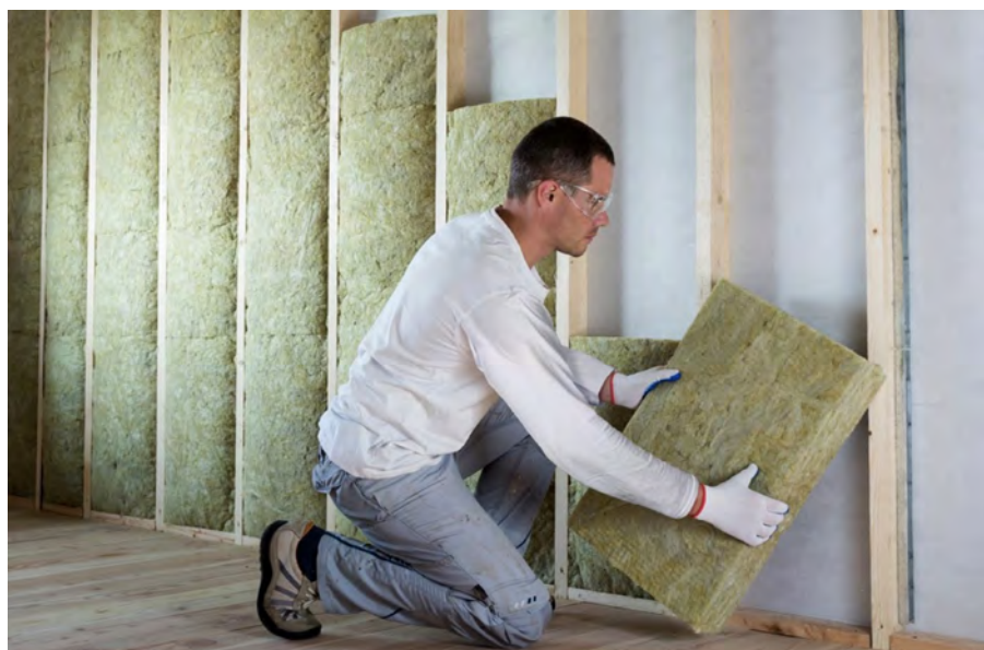
⚡ Å isolere huset kan være smart for å spare strøm. (Foto: Byggmakker)
