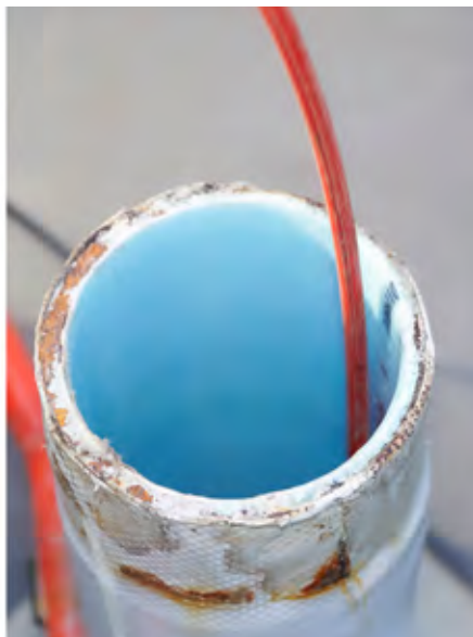
Med rørfornying trekkes en plastmettet «strømpe» gjennom eksisterende rør og herdes til et nytt rør.»
