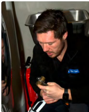
▲ Lars Zimmermann brukte en snau time på å installere vannmåler, vannmålerkonsoll, en kuleventil, tilbakeslagsventil og stoppekran.
