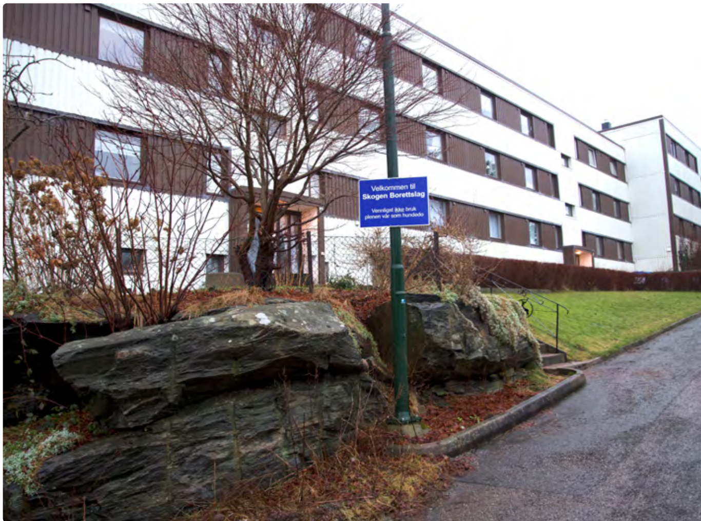
⏏ Blokkene i Skogen Borettslag, som ble bygd på slutten av 60-tallet, hadde en stor tomt som nå er solgt. Inntekter fra salget går til rehabilitering.
