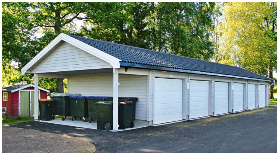
Eksempel på rekkegarasje.
