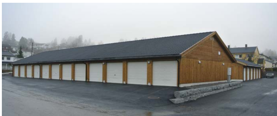
Slik kan også et garasjeanlegg se ut, i dette er det til sammen 136 garasjerom.
