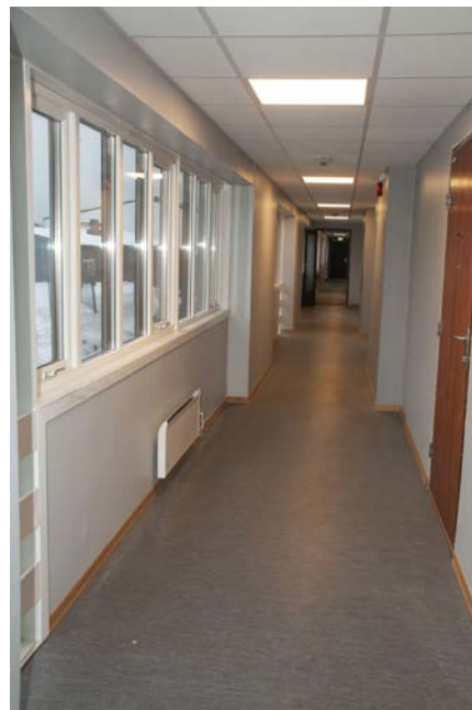
⌘ Korridorene er malt fint opp, takene er senket og har fått effektiv LED-belysning med bevegelsessensorer. Arbeidene er utført av VEF, Malermester Knutson og AS Elektrisk.
