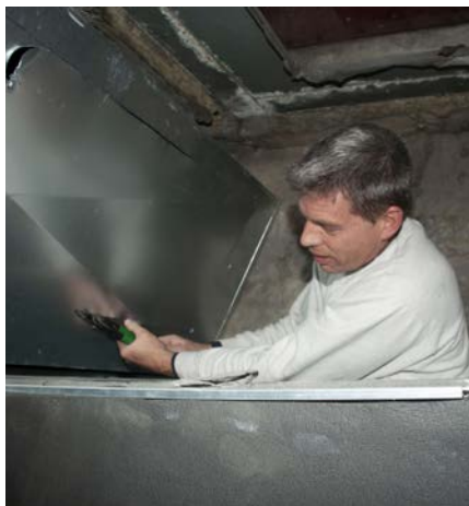
⌘ Ventec Service AS har prosjektert det nye ventilasjonsanlegget, og overlatt monteringen til Olaf Sørli, daglig leder i Sør Blikk og Ventilasjon AS.
