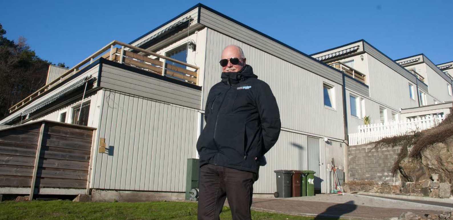
➤ Styreleder i Epleveien Borettslag på Hånes, André Torkelsen, foran den nyrenoverte terrasseblokka.
