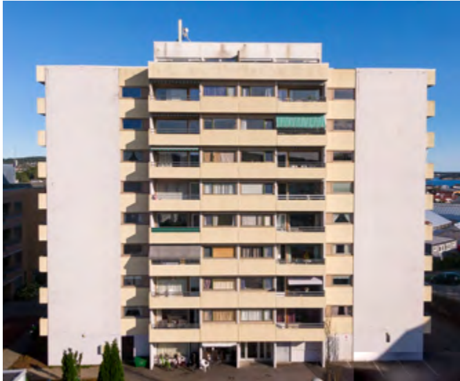
⤴ Slik så blokka ut før den ble renover.
