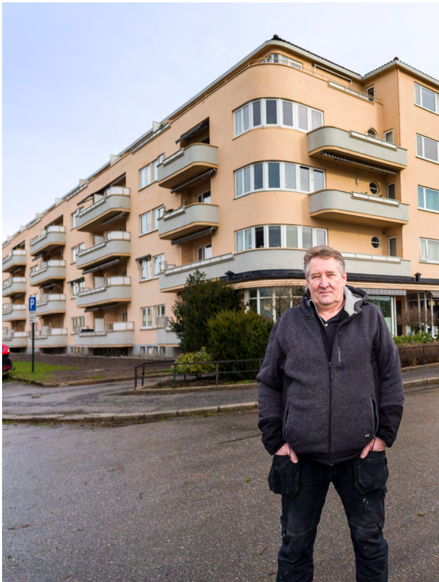
⌘ Vaktmester Kjell Hildebrandt (t.v) og styreleder Kjell Arnvard foran karakteristiske Solbygg, tegnet av arkitekt Thilo Schoder.
