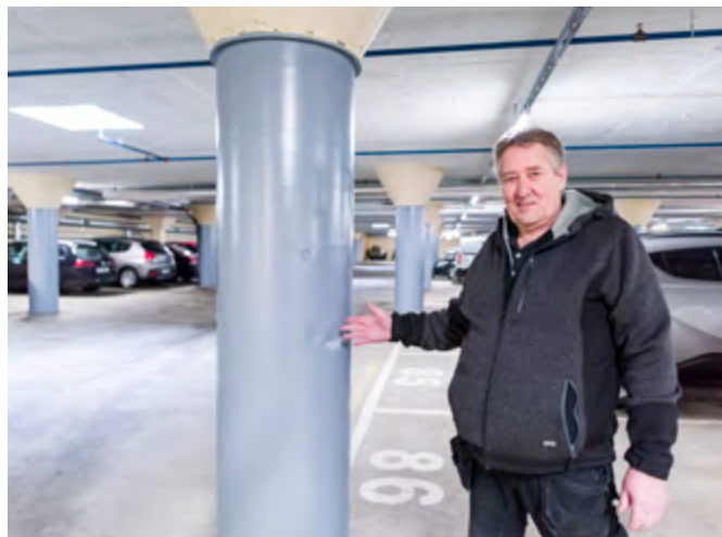
➤ Vaktmester Kjell Hildebrandt i parkeringskjelleren, hvor de digre bæresøylene ble laget av 40 torpedorør fra Marvika.
