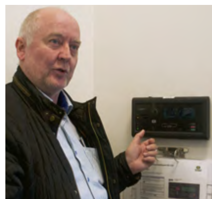
⤴ På panelet på veggen vil det varsles om hvor en brann oppstår.
