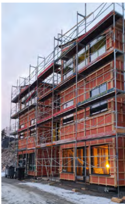
⌘ Bygg 5 - også her er arbeidet godt i gang.
