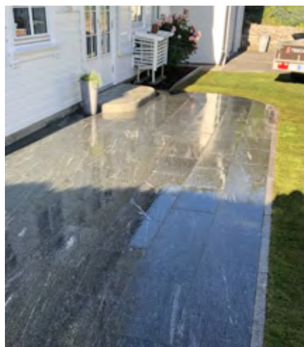
⌘ Platting laget med granitt heller, så godt som vedlikeholdsfritt.
