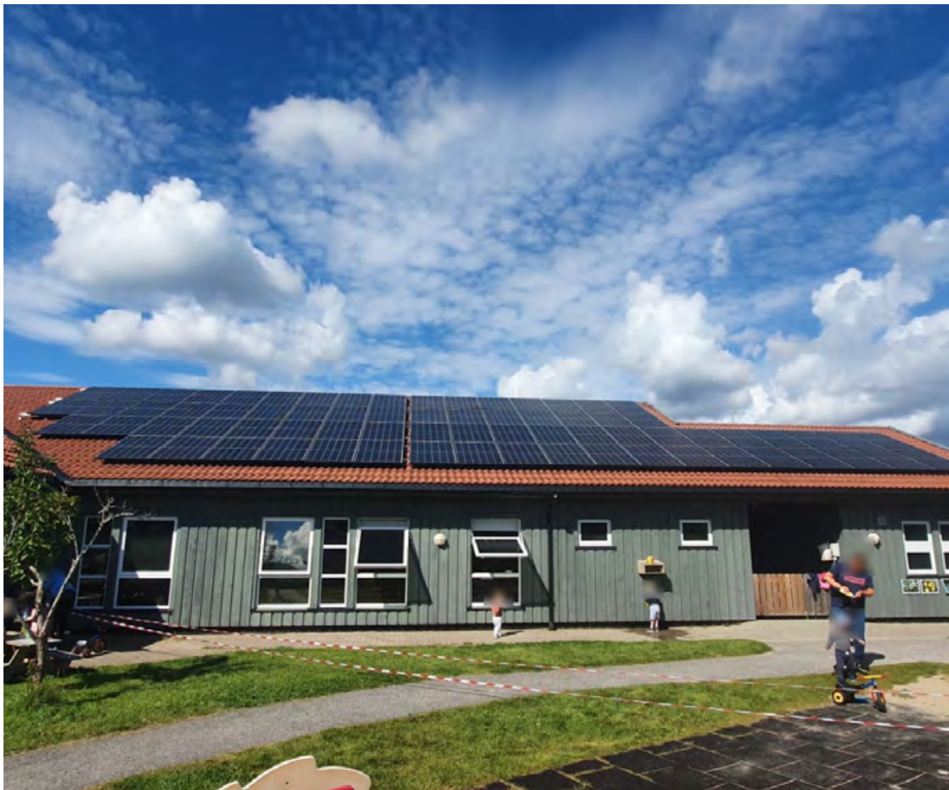
Tratec AS Elektrisk har hatt ansvaret for montering av solcellepanelet på Smååsane Barnehage i Vennesla.
