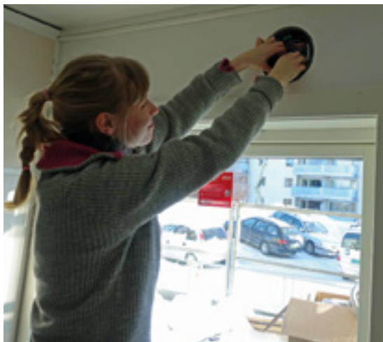
Lisbeth Anette Holsæter i Argon Elektro monterer Lunos-ventiler som gir frisk og forvarmet luft rett inn gjennom veggen i Nardo Søndre Borettslag.
