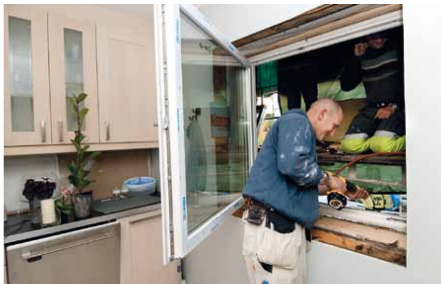
Mirslav Siman skifter ut de gamle vinduene til nye tre lags PVC-vinduer.
