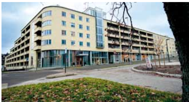
Det er Dyrvik Arkitekter som har tegnet Hovedgårdstunet Borettslag, Kruse Smith stod for byggingen.
