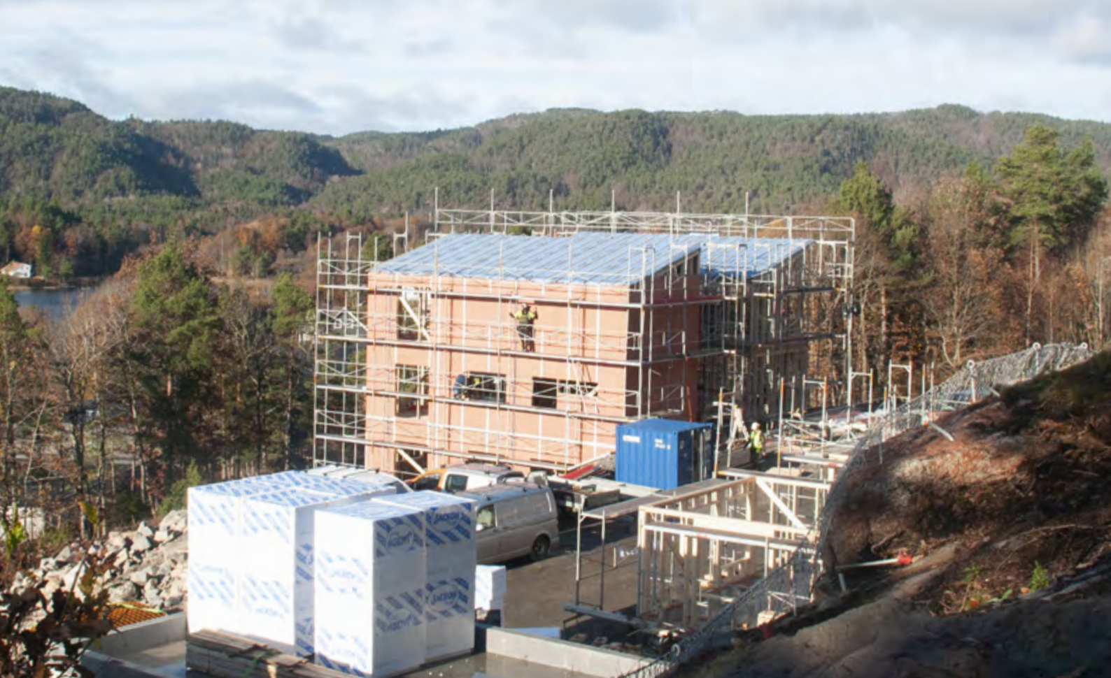
⤴ Det er full aktivitet i Justviklia. Grunnarbeidene i trinn 1 er ferdige, og nå er byggene i ferd med å reise seg.
