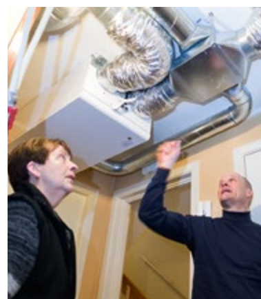
– Hver leilighet har fått ventilasjonsanlegg med varmegjenvinning og beboerne kan styre innetemperaturen selv, sier energirådgiver Bruce Bergendoff til Hedvig Bjørndahl
