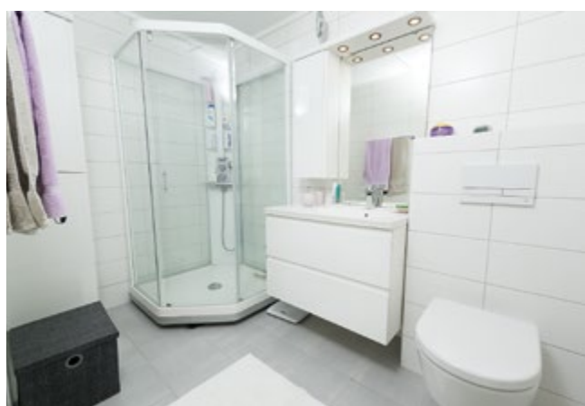
Aamodt VVS la varmekabler i gulvet og bygget nytt, lyst og moderne bad.
