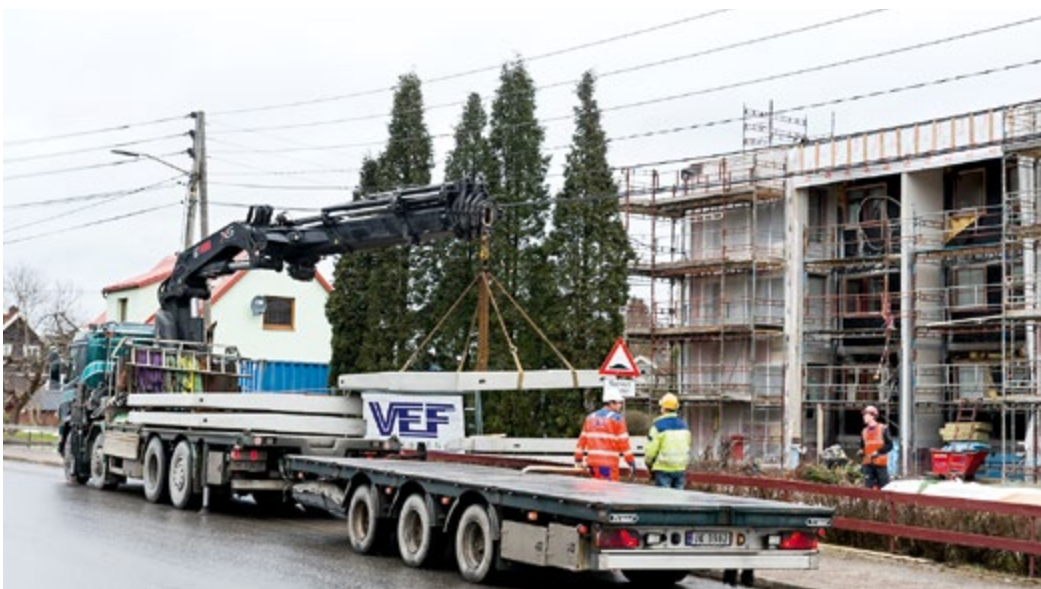
Her er gulvelementene til de nye balkongene i ferd med å bli heist på plass.
