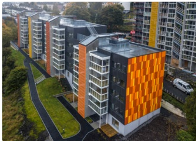
⬆ Solheimslie Borettslag i Bergen måtte rehabiliteres og valgte mørk hovedfarge på alle bygg, men lyste opp fasaden opp med elementer i rødt, gult og oransje.
