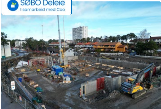
◀ Sånn så det ut på byggeplassen i begynnelsen av februar.
