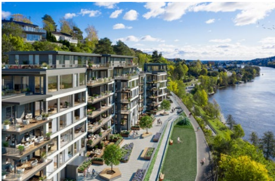
Kokleheia Amfi er bygget inn i terrenget – fra alle leilighetene er det panoramautsikt.
