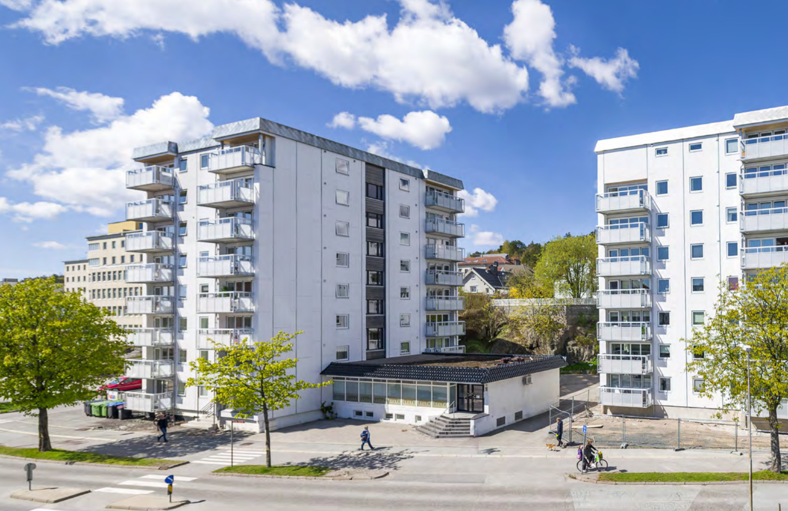
De tre blokkene i Tordenskjoldsgate er flottere enn noen sinne. Balco har hatt ansvaret for de nye balkongene, som nå er blitt 70 cm bredere. (Foto; Balco, Kjell Inge Søreide)
