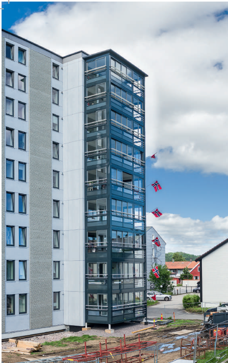
erdig. Boligblokka er fornyet fra topp til tå med blant annet nye balkonger og ny
