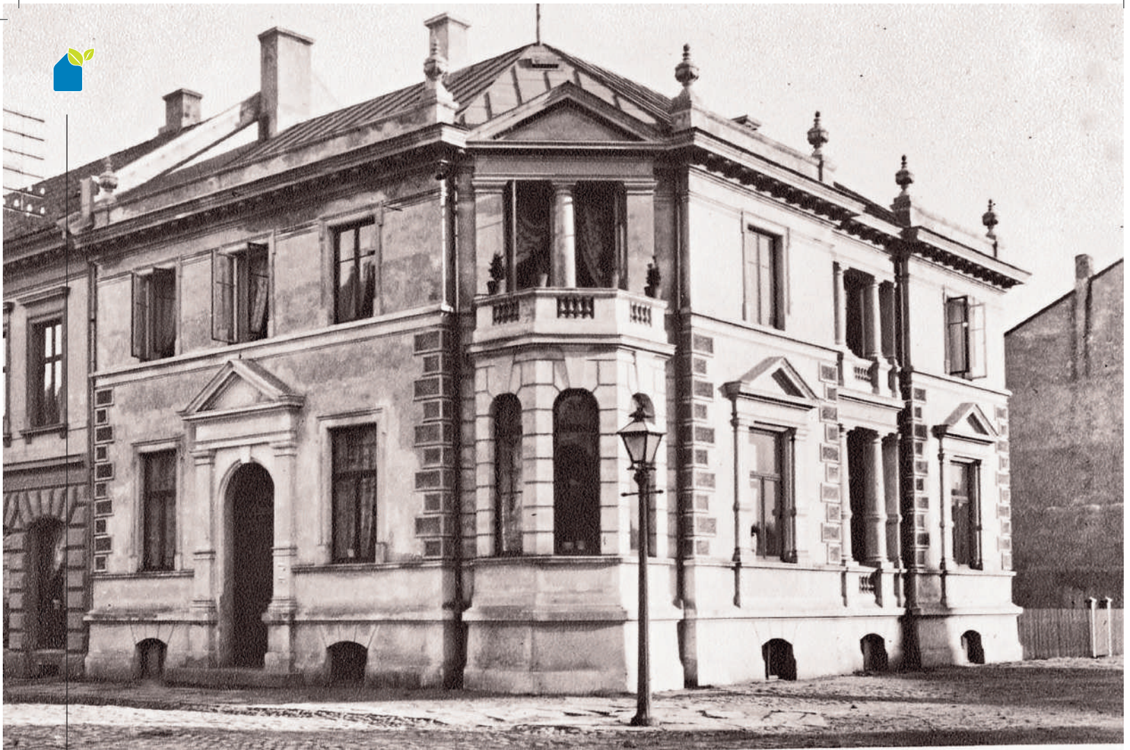
1894: Rådhusgata 14 bygd opp i mur etter bybrannen to år tidligere. Foto fra Live Danbolt Drange
