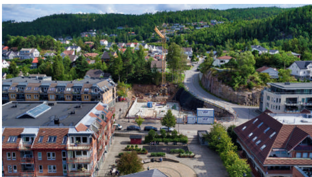
Nå begynner bygget i Sentrumsvegen å ta form.
