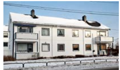
Slik så de ut før rehabiliteringen startet.
