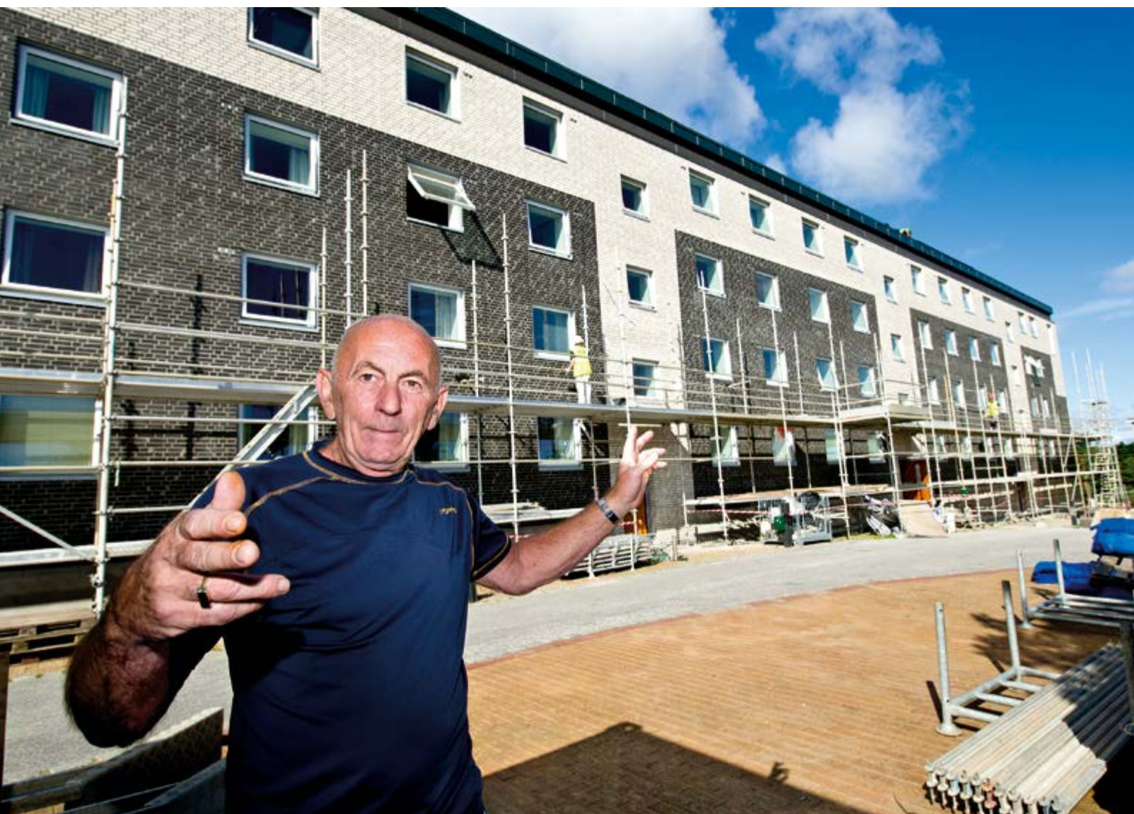
Styreleder Thor Øystein Solli i Gullveien 8 borettslag er glad for at byggeperioden snart er over og svært tilfreds med de nye fasadene, balkongene og satsingen på lavenergi.
