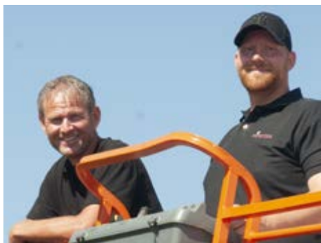
⚡ Svein Tore Tveite (t.v) og Lars Arneberg sørger for nye piper til rekkehusleiligheter på Lund nå før fyringssesongen setter inn.
