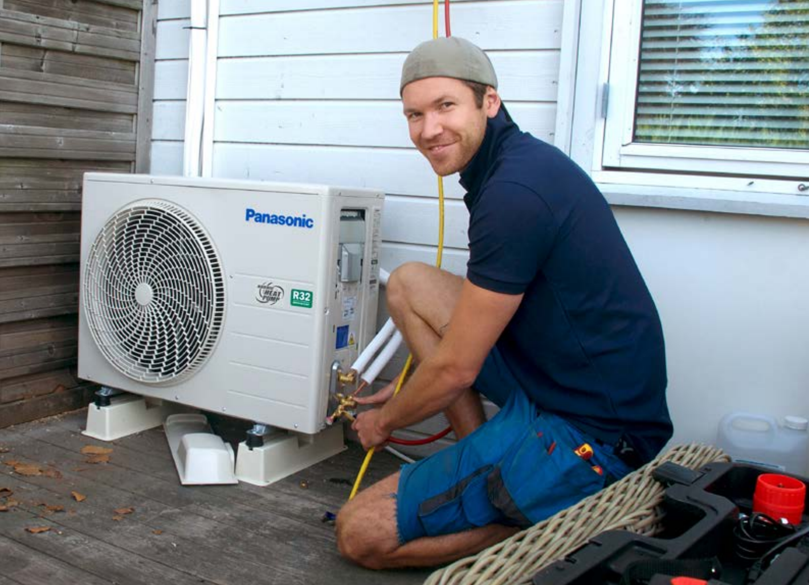
⌘ Thomas Nodeland, eier av Sørlandet Varmepumpe Service AS, har det travelt med å montere nye varmepumper.
