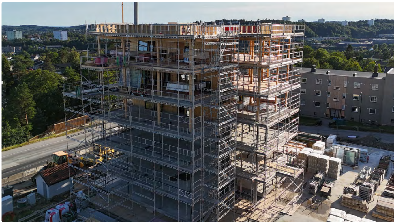
Bygg nummer 1 i første byggetrinn reiser seg – dronebildet er tatt i august.
