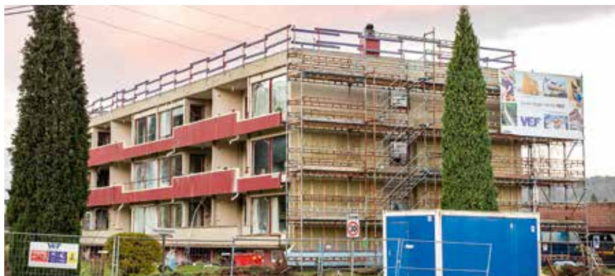
Rehabiliteringen av Moen Borettslag i Hunsfosvegen i Vennesla er i full gang. (Foto: Eirik Vigsnes)
