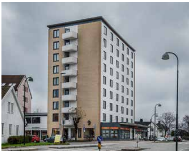
Marviksveien 9 framstår som en ny boligblokk etter omfattende restaurering og borettslaget er nominert til byggepris.
