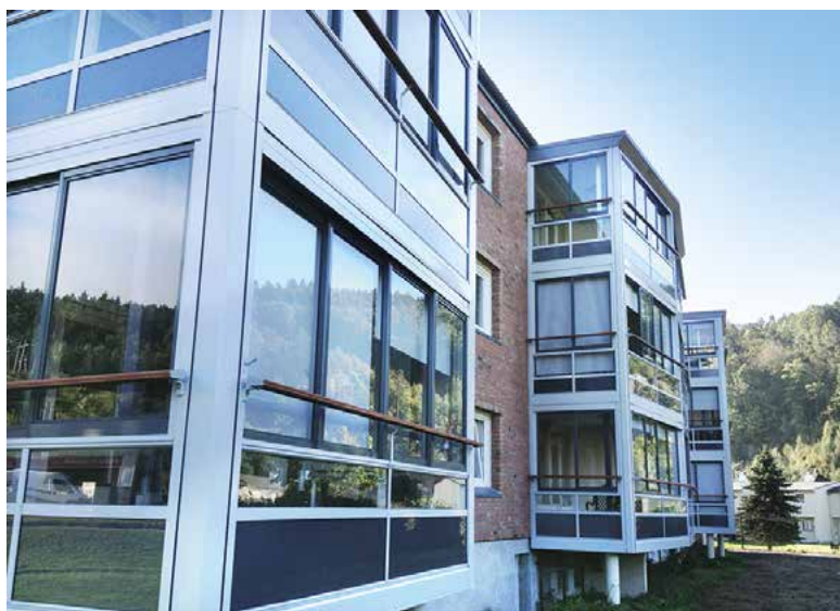
Balkongene i Borettslaget Setesdalsveien 71 er innglasset på eksisterende betonggulv, siden gulvet var nytt for et par år siden.
