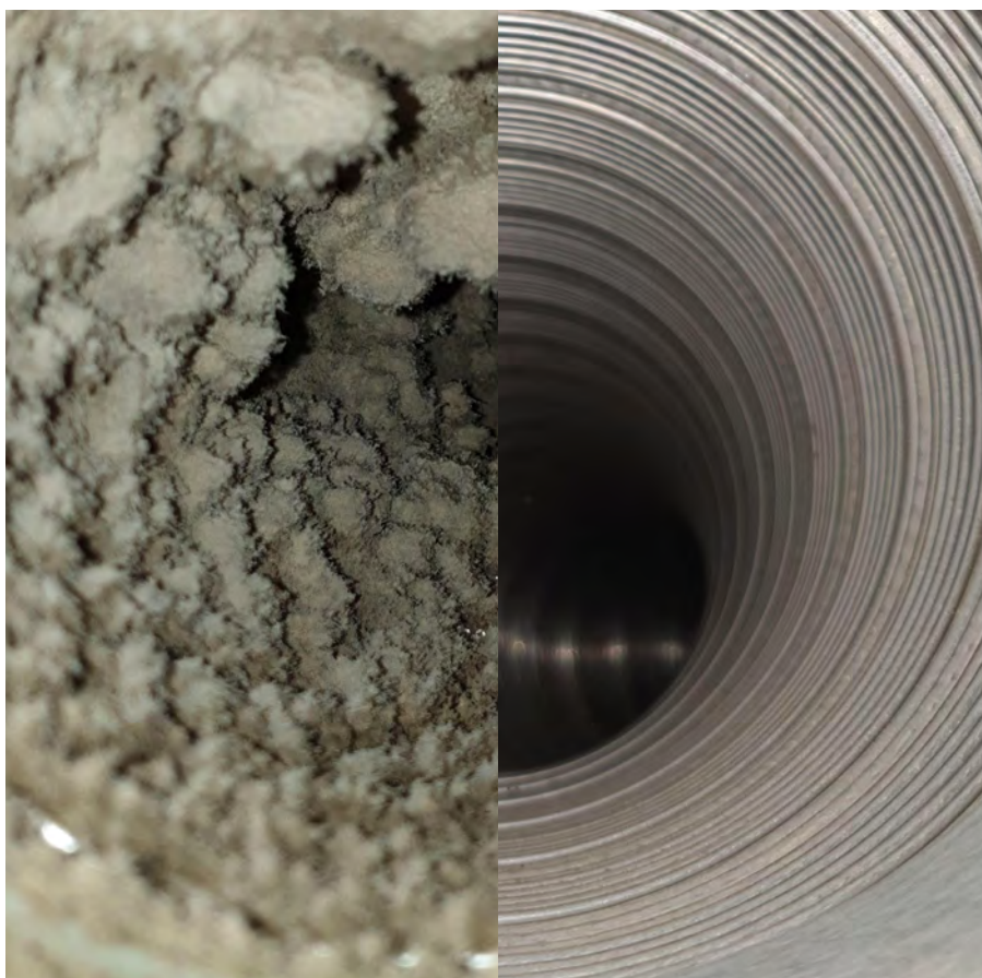
➤ Avtrekkskanaler før og etter rens.
