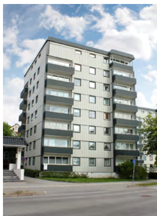
➤ Slik så blokkene ut før rehabiliteringen.
