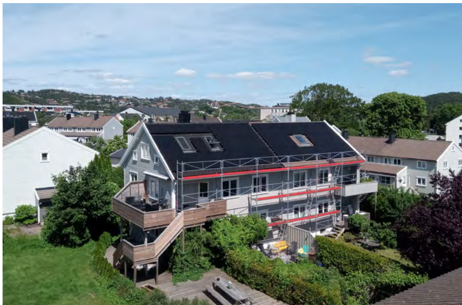
⚡ Her ble de siste solcellepanelene montert i Valhallabakken Borettslag. (Foto: Tradewinds Solar AS).
