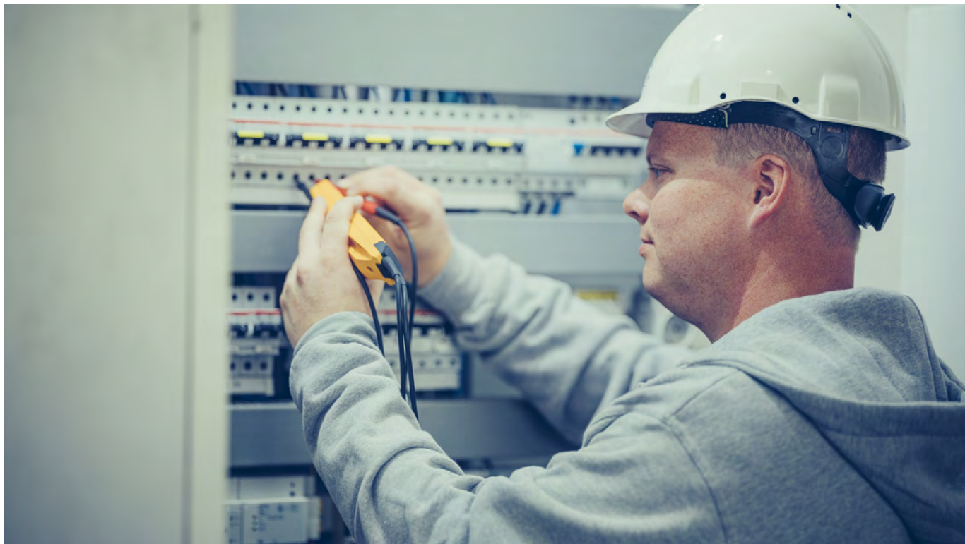
⌘ Under en kontroll sjekkes sikringsskapet.
