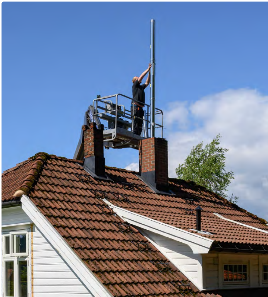
▲ Pipefiks rehabiliterer piper og gir 25 års garanti på de nye piperørene.
