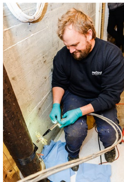
Bjørn Ahlsted, arbeidsleder i Proline, gjør seg klar til å behandle 20 meter avløpsrør fra den ene blokka og ut til kummen.
