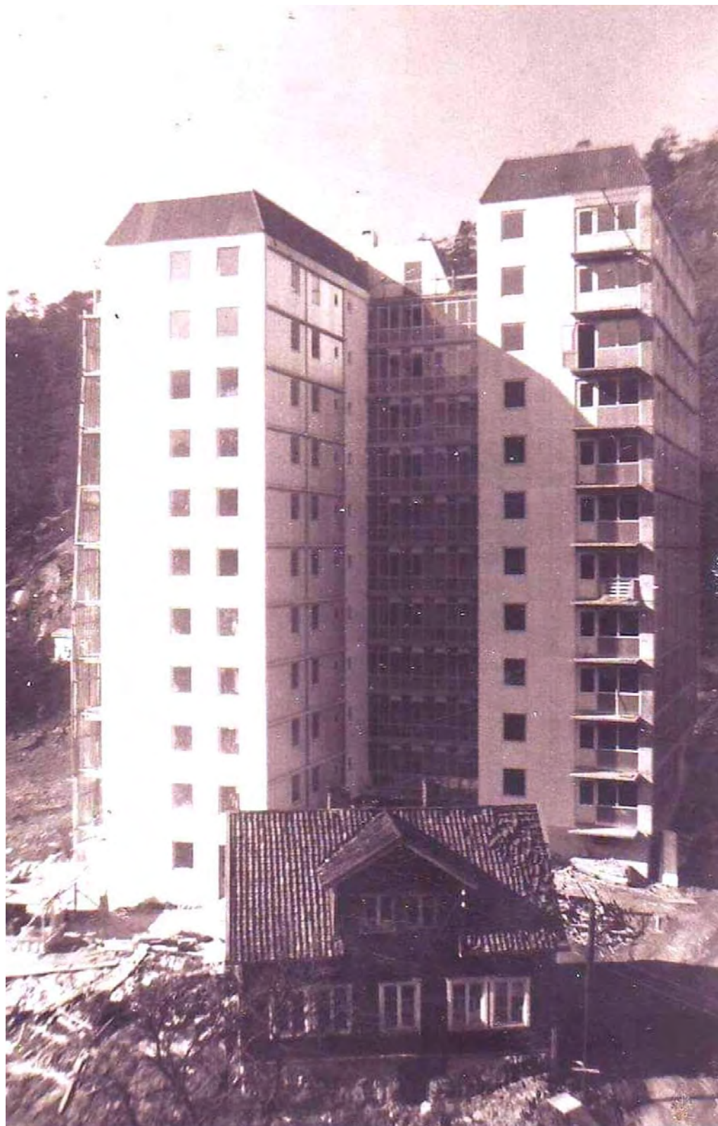
⌘ Småbruket like før det blir revet – det ble brukt til brakke av arbeiderne som bygde blokkene. Høyblokka i Gamle Mandalsvei 16 i bakgrunnen. (Alle foto – lånt av Kjell Arne Trontveit)
