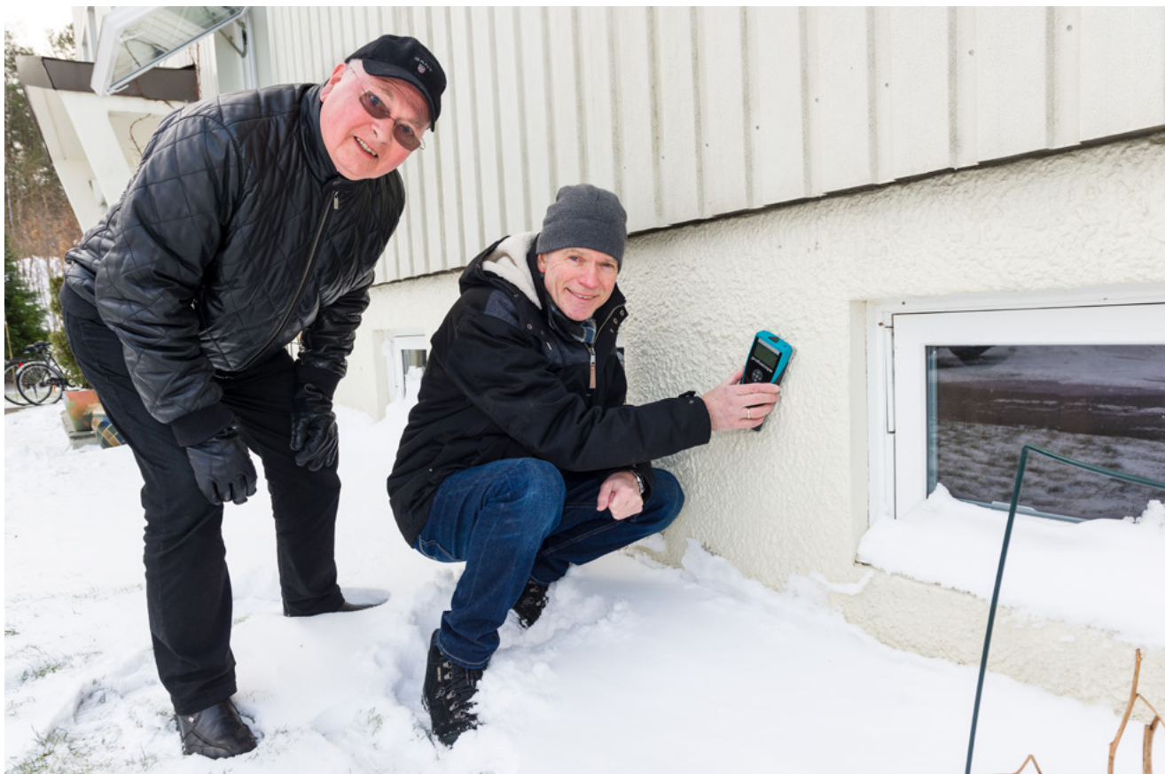
Styreleder i Svarttjønneveien Borettslag Dag Thorbjørnsen (t.v) og teknisk sjef i Sørlandet Boligbyggelag Odd Helge Moen sjekker grunnmuren.
