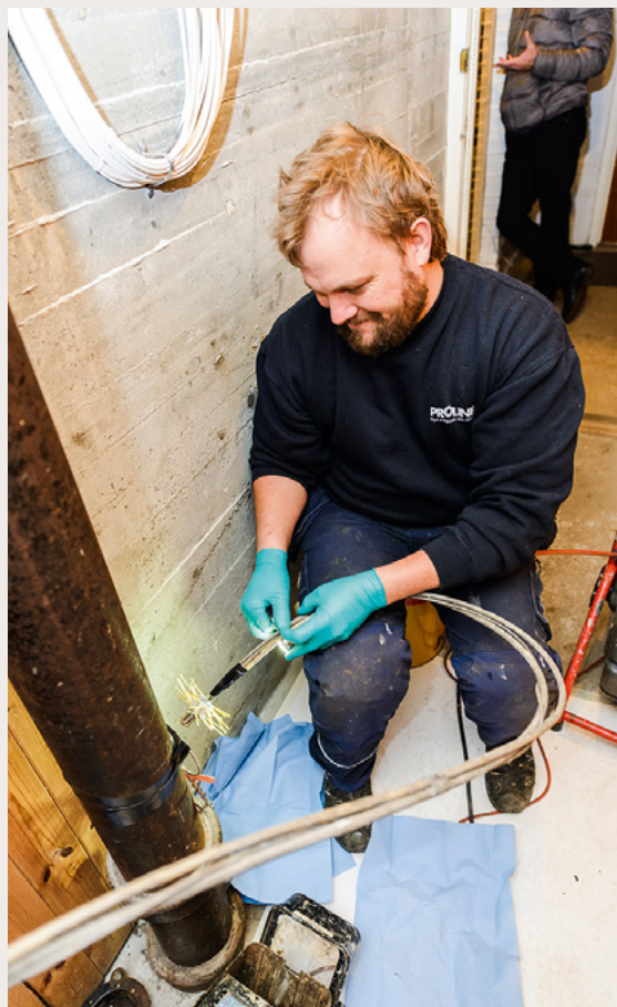
Bjørn Ahlsted, arbeidsleder i Proline, gjør seg klar til å behandle 20 meter avløpsrør. (Foto: Eirik Vigsnes)
