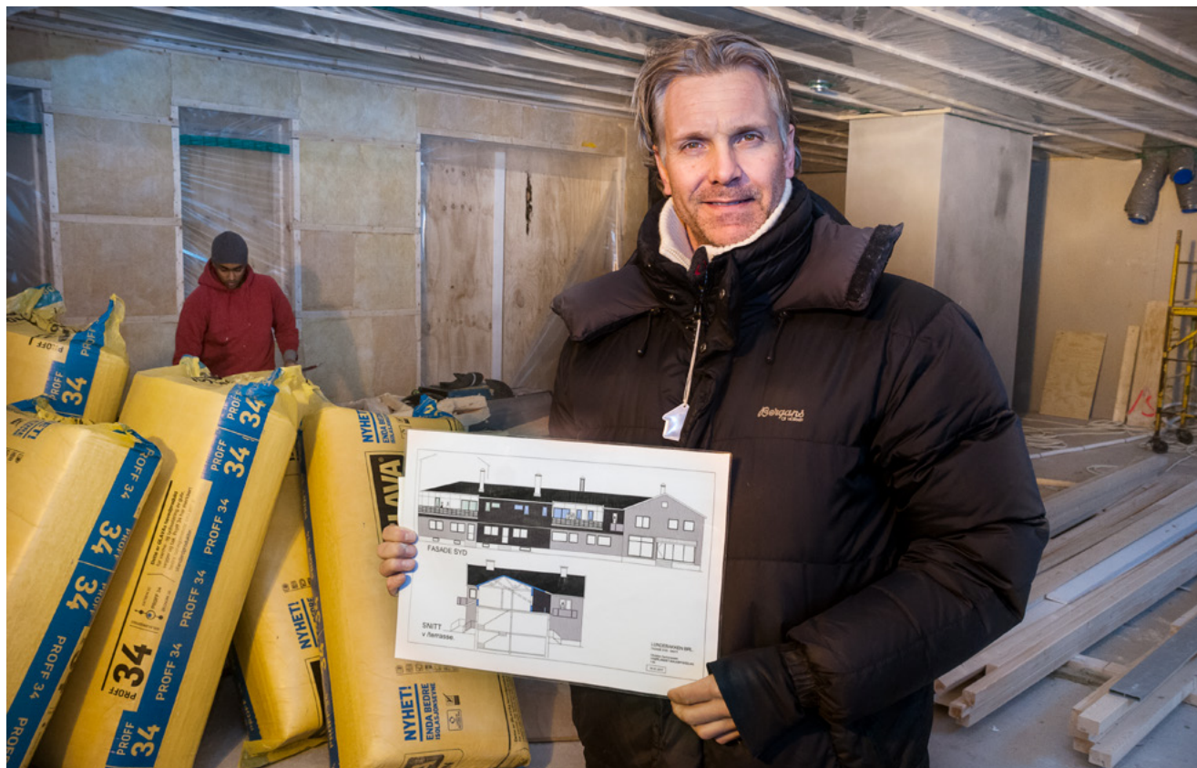
– Det er stor byggeaktivitet i Lundebakken Borettslag. Snart står to moderne leiligheter ferdig, sier Christian Zachariassen i Sørlandet Boligbyggelag.
