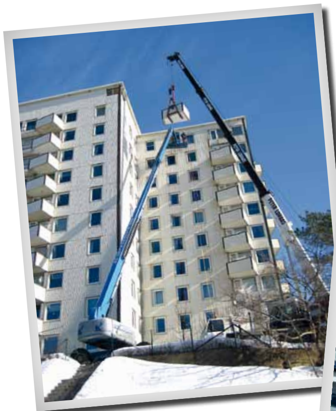
Våren 2010 ble alle de gamle balkongene i Tinnheiveien 11 revet. Her blir Aunes balkong i tiende etasje løftet vekk med kran.
