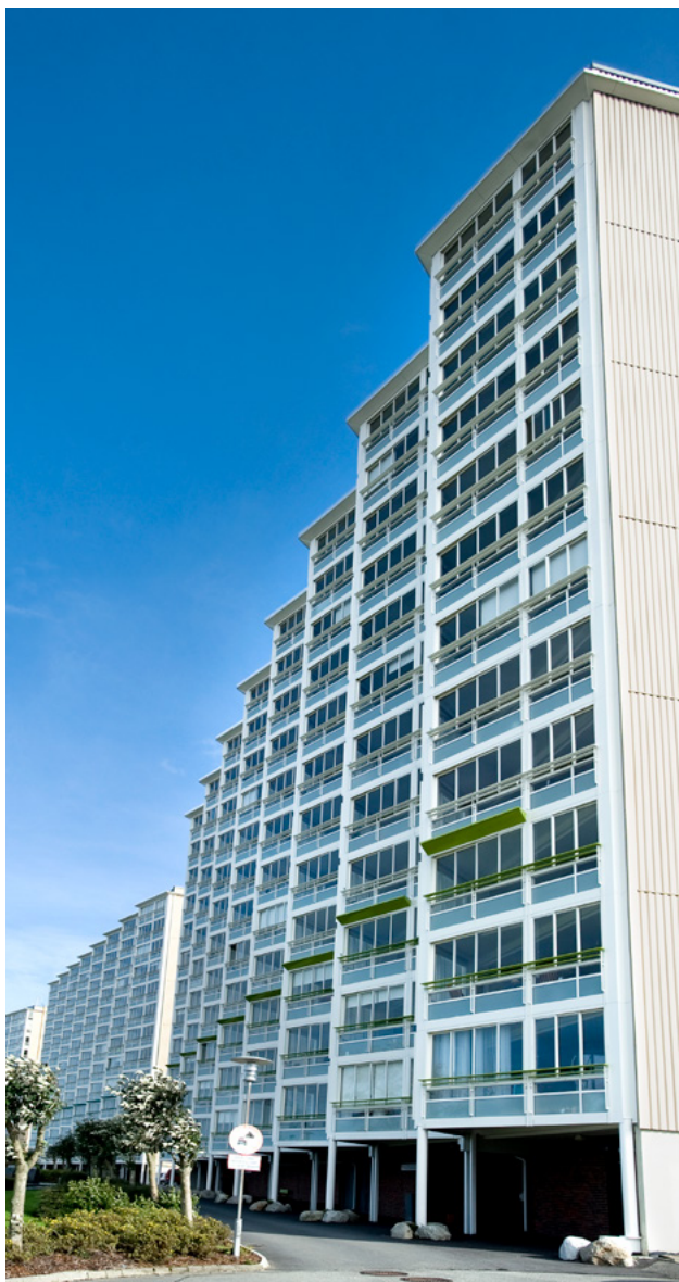
Borettslaget Madlamark i Stavanger, her ble det bygd 294 nye balkonger i 2010.
