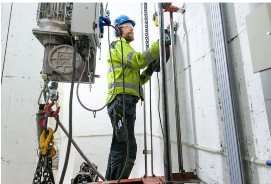
Frank Andersen i full sving med demontering av den gamle heisen.
