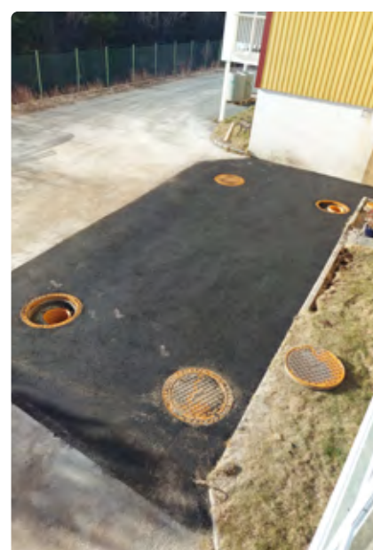
I løpet av to uker ble det boret fire energibrønner på 200 meters dybde. Foto: Bente Eriksen
