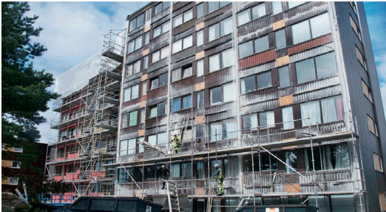
Arbeidet med rehabiliteringen av de tre blokkene i Kollen Borettslag i Kjerrheia er i full gang.
