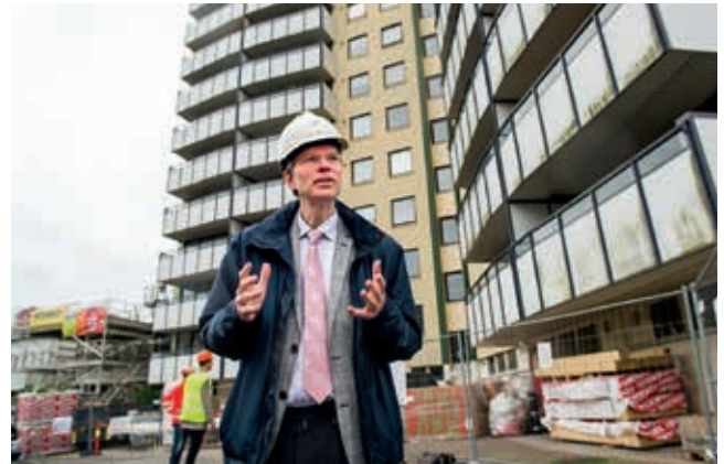
Teknisk sjef Odd Helge Moen har i om lag to år jobbet sammen med styret i Stjernehus Borettslag for å komme fram til gode og miljøvennlige rehabiliterings-løsninger for beboerne.
