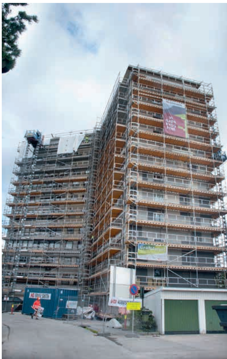
For en måned siden startet arbeidet med å bygge om den 11 etasjers høye Stjernehus-blokka på Tinnheia til lavenergiboliger.
