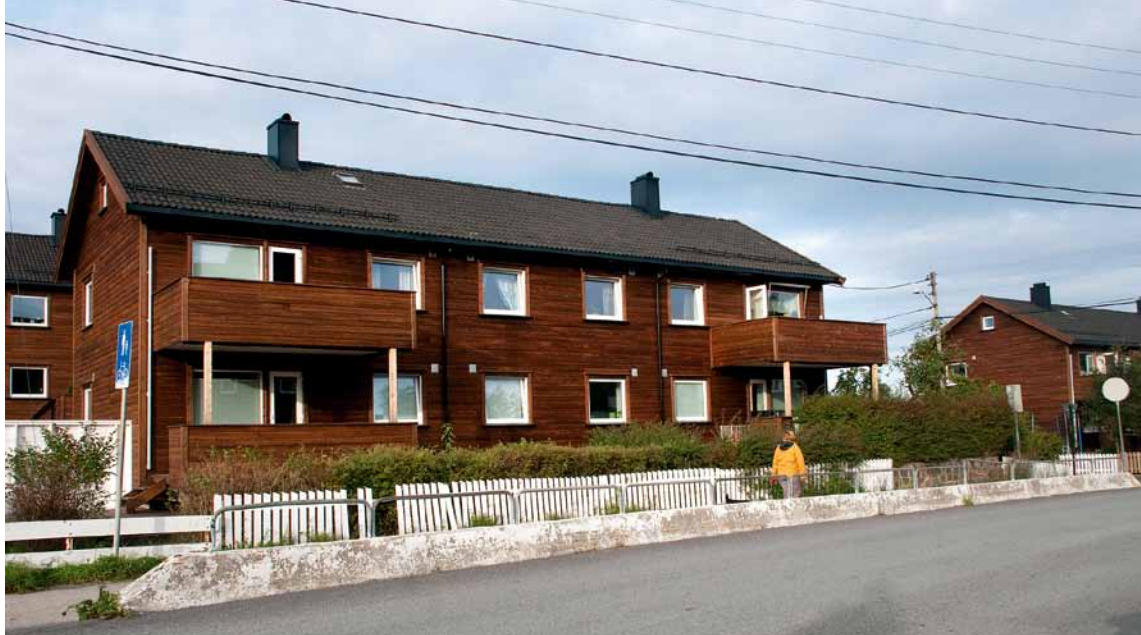
Vågsbygd Borettslag er restaurert og oppgradert til lavenergistandard.
