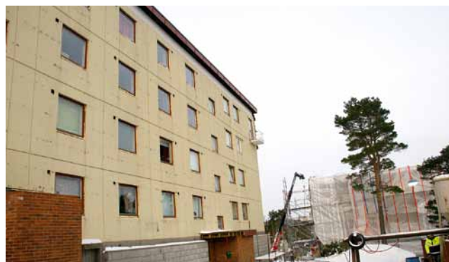
Blokkene i Gullveien 8 Borettslag er ribbet og lite tiltalende mens rehabiliteringsjobben pågår.
