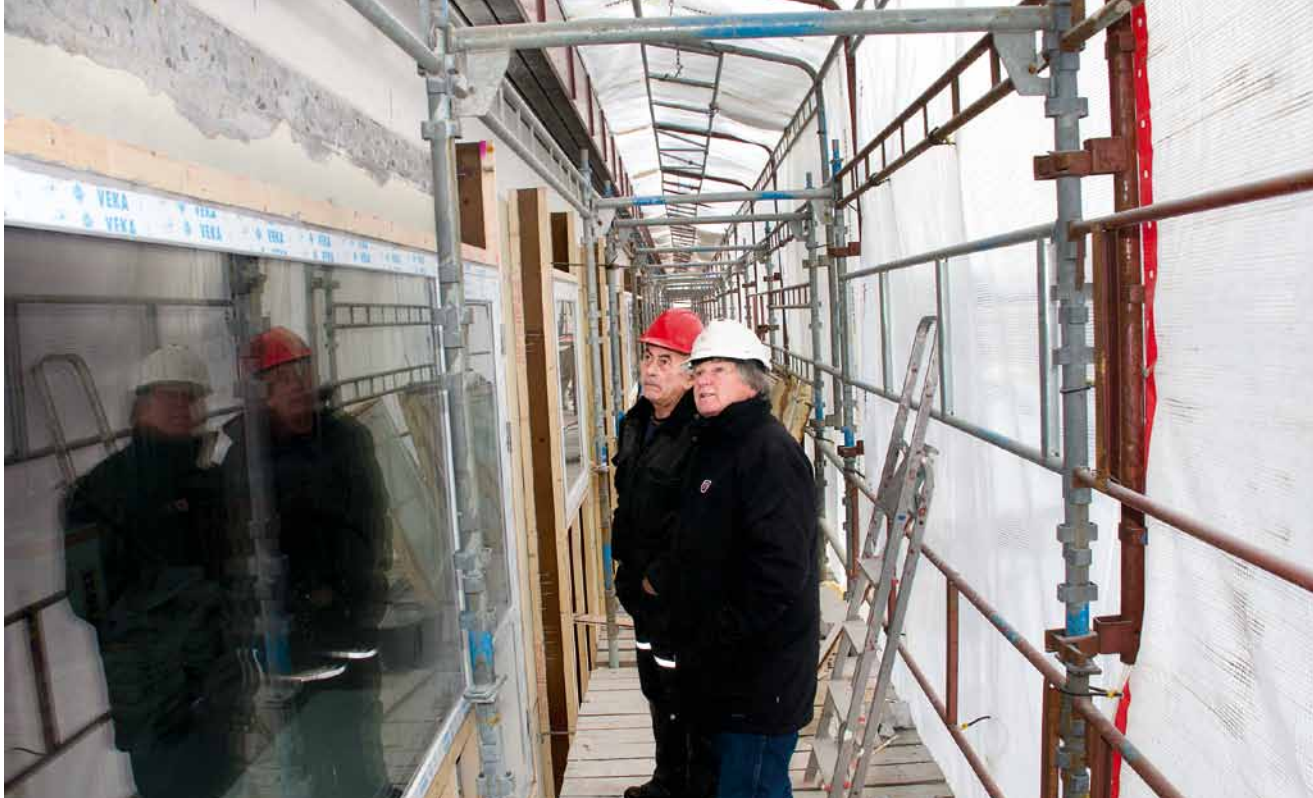
– Det settes inn store tre-lags energi vinduer, opprinnelig var det store vindusruter da blokkene bli bygd på slutten av 60-tallet, forklarer Arild Kristiansen fra Sørlandet Boligbyggelag. Borettslagsleder Thor Øystein Solli tar en titt på de nye vinduene.
