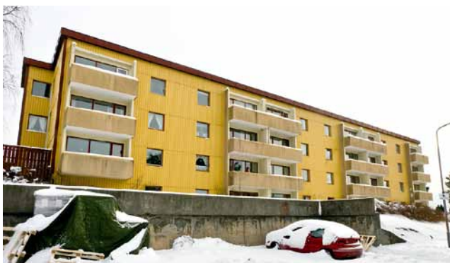
Slik ser blokka i Gullveien 8 Borettslag ut før rehabilitering.
