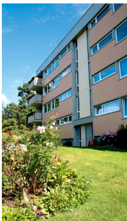
Tinnbo Borettslag er restaurert og oppgradert til lavenergistandard.
